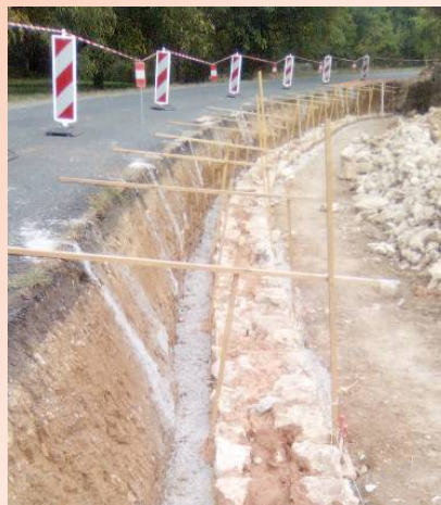
Assise en béton et reconstruction avec les pierres récupérées. Montage d'un gabarit en bois pour garder la forme de l'ancienne structure.
