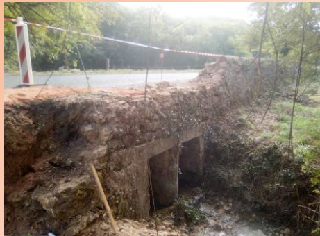
Mise à bas de l'ancienne architecture. Le pont en lui-même est gardé intact.
