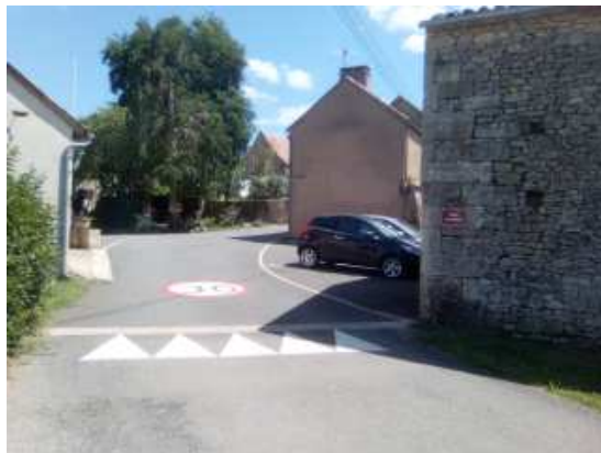
Entrée de la zone par la "Route des noyers"
