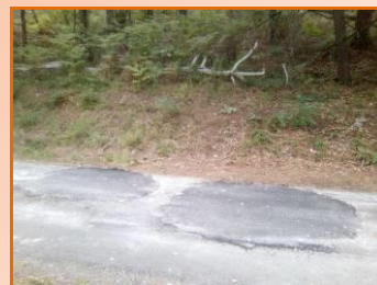
Quelques taches sur la chaussée pour un meilleur confort de conduite
