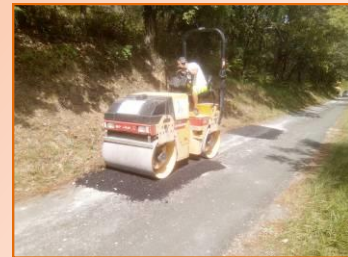
Empierrage/Compactage du calcaire
