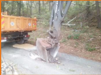
Rabotage/décaissage
