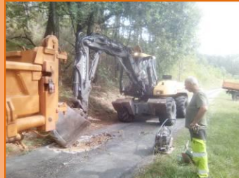
Empierrage/Compactage du calcaire
