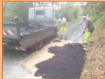
Mise en place d'une couche "enrobé à froid" et compactage
