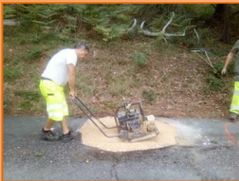
Mise en place d'une couche "enrobé à froid" et compactage
