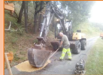
Empierrage/Compactage du calcaire
